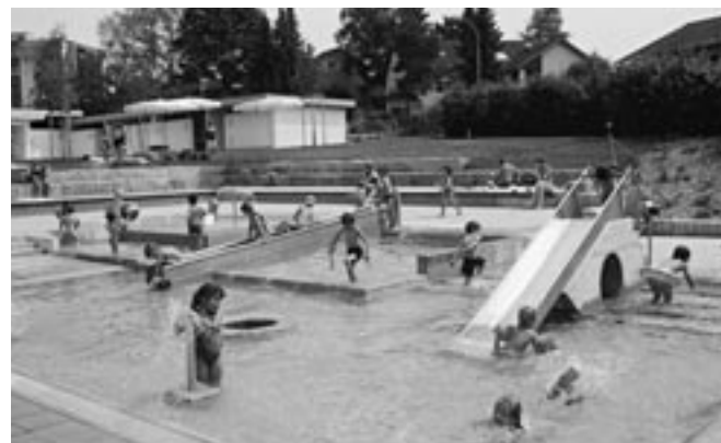
Schwimmbad Hinwil, Baujahr 2000. Die Wasserflächen sind in vier Becken mit unterschiedlichen Wassertiefen aufgeteilt.
