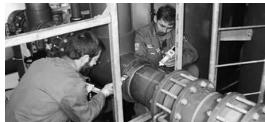
Zur besseren Anpassung des Bandes an das T-Stück wurde ein Band in Stücke geschnitten und kreisförmig um das T-Stück gelegt.
