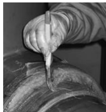
Das Vlies wird während des Aufwickelns mit dem Klebstoff getränkt.
