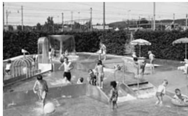
Planschbecken Gossau SG, Baujahr 1998. Bei dieser Anlage fehlen die Aufenthaltszonen für Eltern als sinnvolle Ergänzung zu den reinen Beckenflächen.
