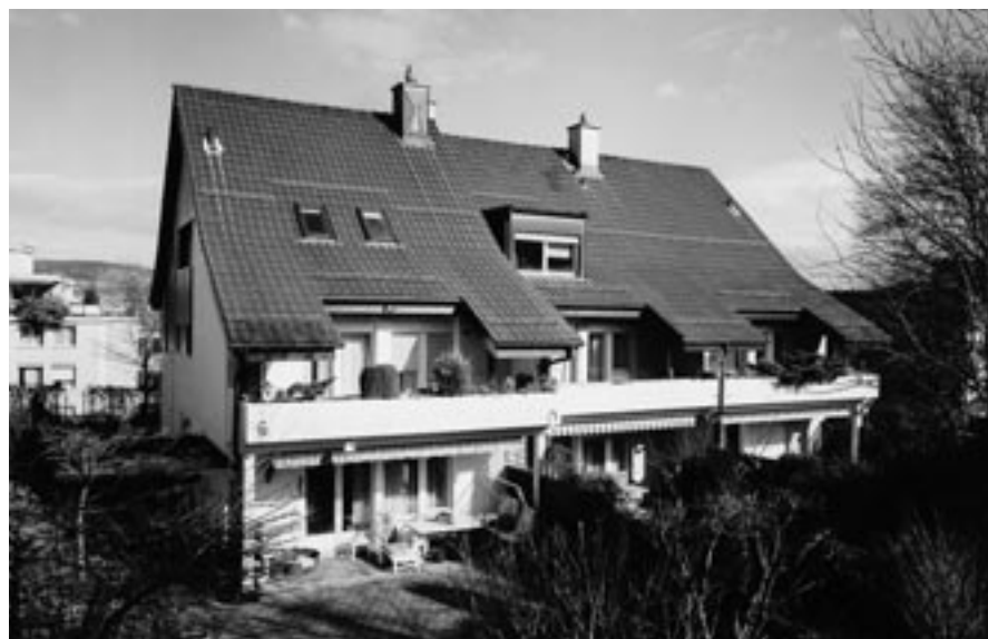
Kaum sichtbar: Die neue Abgasleitung an der linken Aussenwand an einem der Häuser an der Aubrigstrasse in der Au/Wädenswil ZH.
