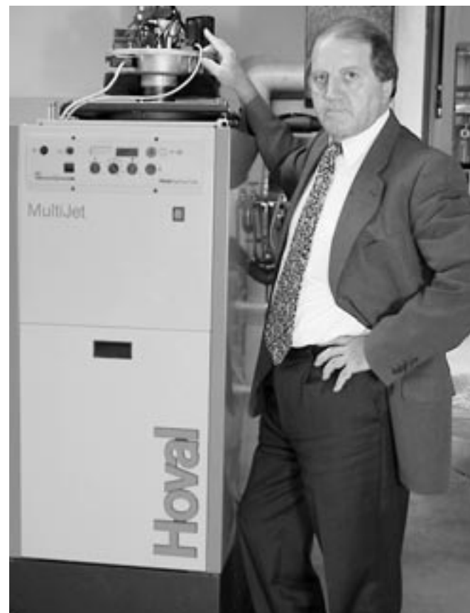
Der «MultiJet» von Hoval nutzt die Wärme des Wasserdampfes der Abgase.
