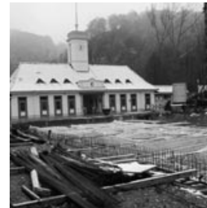
Bauarbeiten am Nichtschwimmerbecken im November 2001.
