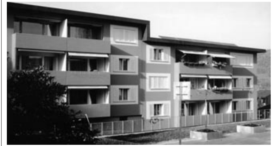
Attraktive Finanzierung von Solarwärme: Für Liegenschaftsbesitzer ist das Contracting attraktiv. Die Kosten der Energieproduktion lassen sich via Nebenkosten abrechnen, die Anlage finanziert der Contractor. (Fotos: Ernst Schweizer AG)
