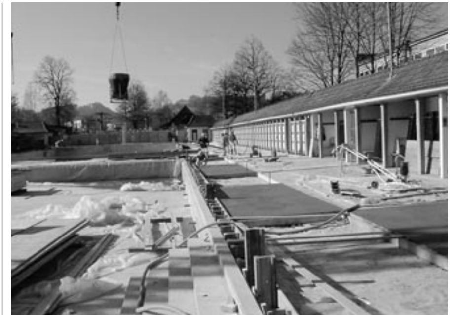
Betonieren der Beckenumgänge im März 2002.
