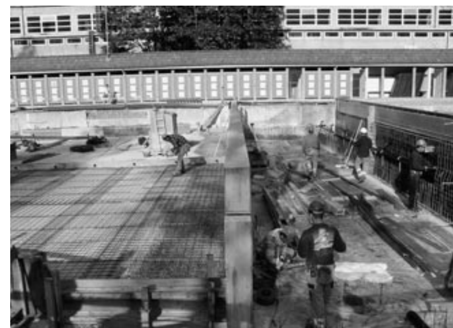
Bau des Ausgleichsbeckens im Oktober 2001.
