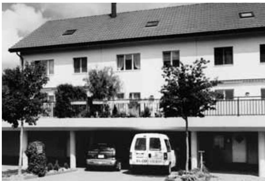
Kaum mehr als 5kW Wärmeleistungsbedarf: Mittelhaus «Im Wygärtli» in Märstetten. (Fotos: Peter Morf/VSG)
