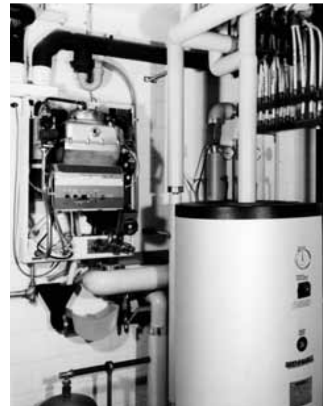
Das Auswechseln des Vormischbrenners (oben im Kessel), der Mischeinrichtung (rund darüber) und der Elektronik sowie der Einbau zweier Blenden reduzierten die Leistung und bringen eine grosse Energieeinsparung.
