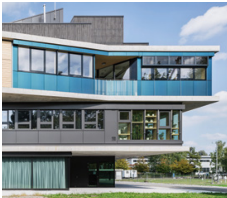
Getreu dem Namen «SolAce» stellt die neue Forschungs-Unit das Sonnenlicht ins Zentrum – zum einen als Energielieferant und zum anderen als wichtigen Komfort- und Gesundheitsfaktor. Bild: Die Südseite der Unit «SolAce» mit der blau-grün verglasten Photovoltaik-Anlage.
