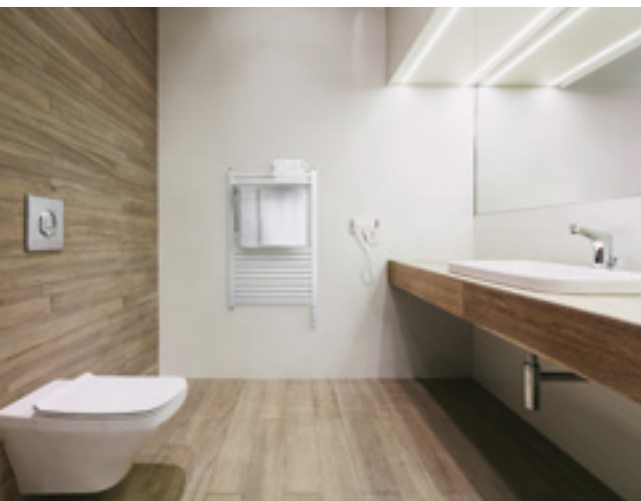
Handtuchwärmer gibt es als Warmwasser-Versionen, im Mixbetrieb oder als rein elektrische Varianten.
