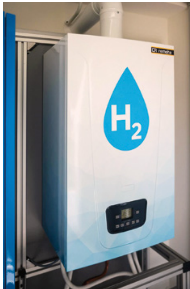
Die mit reinem Wasserstoff betriebene Heizung im Feldtest in Rozenburg NL. Bild: z.V.g.
