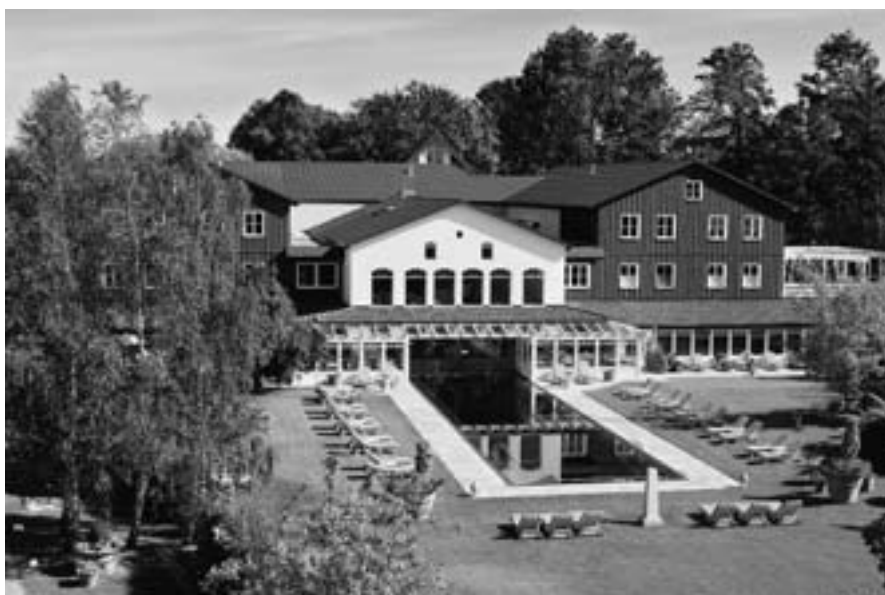
Ein schöner Blick auf das Gebäude und einen Teil der Aussenanlage.
