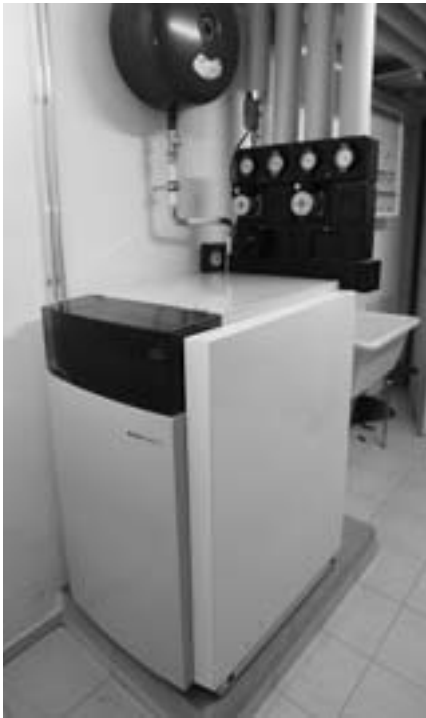
Weniger Energieverbrauch und geringerer Schadstoffausstoss garantiert der Öl-Brennwertkessel Straton von «Elco».
