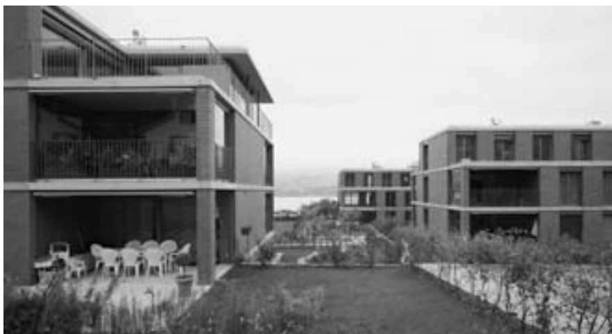
Mit Blick auf den Zürichsee: Überbauung «Sunnehof» in Oberrieden.
