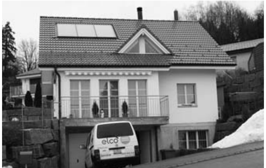
In diesem schmucken Einfamilienhaus der Familie Burri in Weisslingen wurde eine Kombianlage Öl/Solar von «Elco» eingebaut. Die Kollektoren mit 6 m 2 Absorberfläche liefern während rund acht Monaten im Jahr die gesamte Energie für die Warmwasserbereitung.
