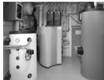
Blick auf den Solarspeicher (rechts) mit dem «Lion» (links).
