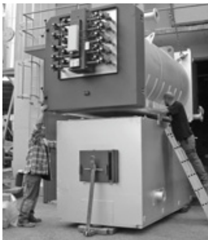
Anlieferung der Feuerungs-Anlage II (Kessel/Rost).
