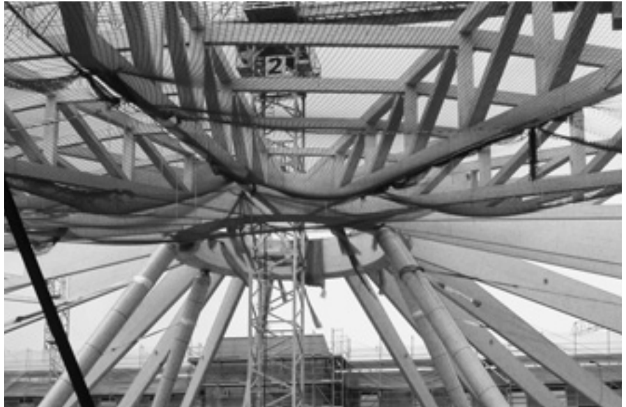
Firstring auf vier Stützen, mit angeschlossenen Fachwerk-Bindern.
