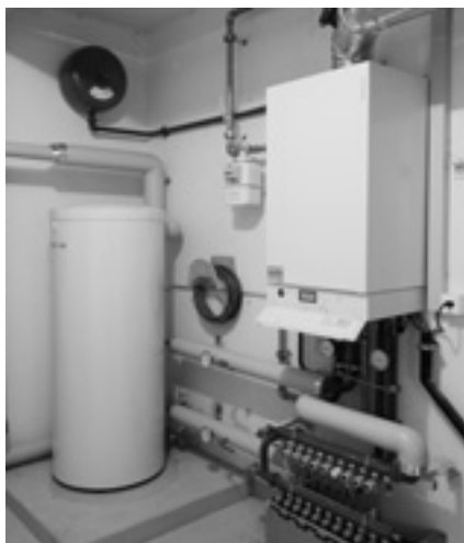
Statt der gemeinsamen alten Heiz-Zentrale für alle Reihenhäuser am Hummelberg in Jona SG hat nun jedes Reihenhäuser dort seine eigene Gas-Heizung.
