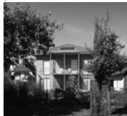
Mit einem effizienten Solarsystem lassen sich heute bis zu 75% des jährlichen Energiebedarfs für Warmwasser decken.
