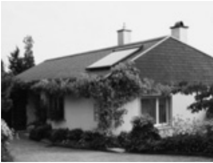
Das Einfamilienhaus von Heinz und Vreni Dätwyler in Kriens. Die Hauptachse des Hauses verläuft in nordsüdlicher Richtung.
