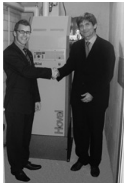
Dr. Rolf Hartl, Geschäftsführer Erdöl-Vereinigung (rechts) und Stefan Fässler, Leiter Kundencenter Zürich, Hoval Herzog AG (links), vor dem neuen Öl-Brennwertheizkessel Hoval MultiJet 25.
