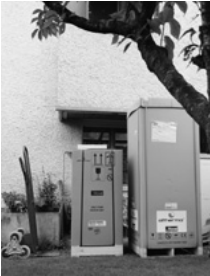
Kompakt und handlich angeliefert, die Hoval Altherma-Wärmepumpe, bereit zum Einbau.
