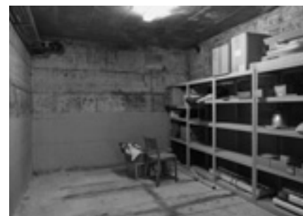
Neuer Lagerraum dank Gasheizung. Weitere Gestelle werden folgen ...
